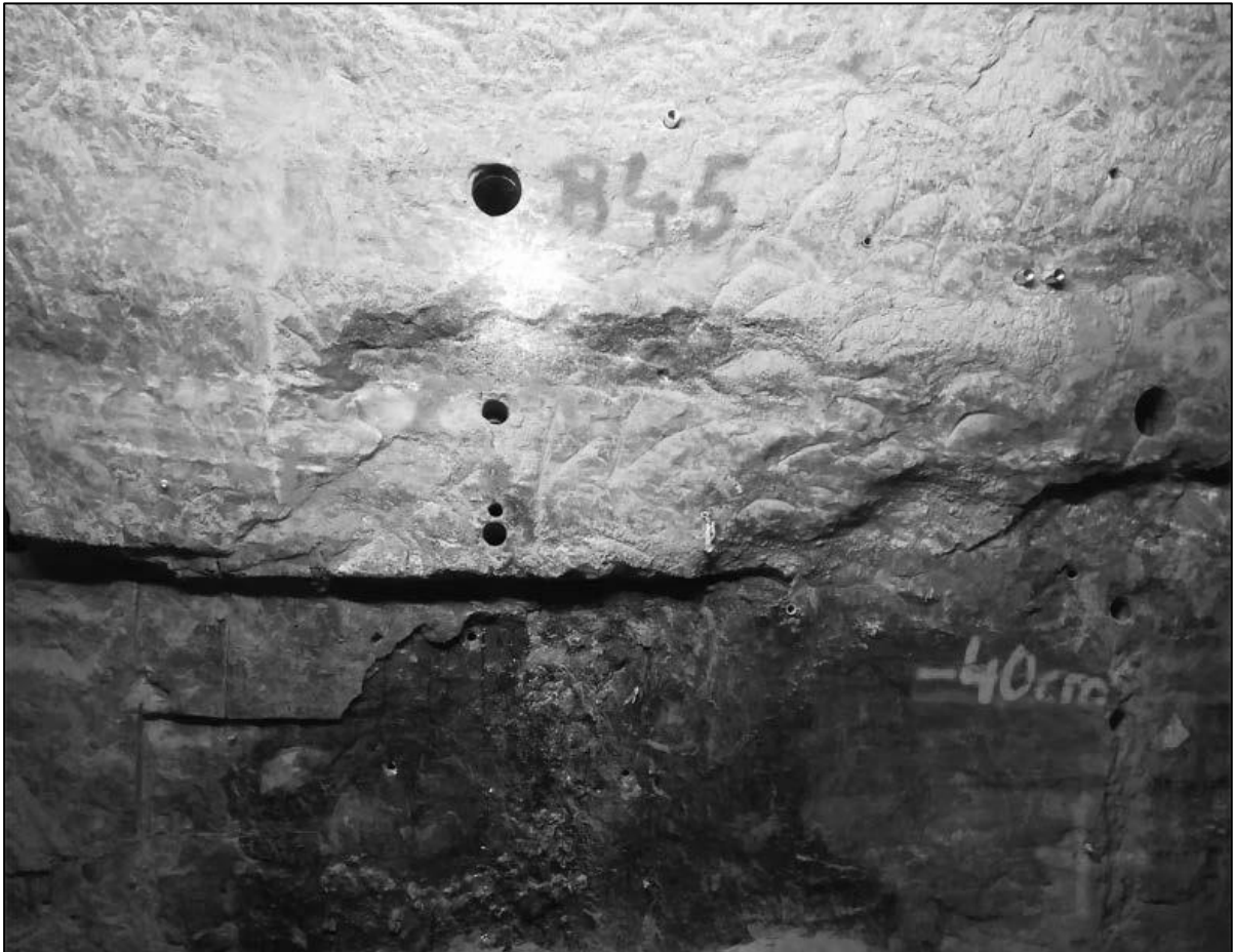
Abbildung 27: Lage der Bohrungen B45 und B46 im Streckenverschlussbauwerk GV2
