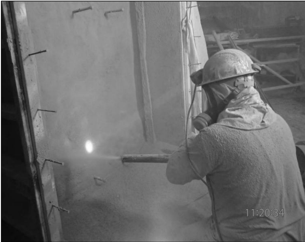
Abbildung 149: Düsenführer beim Spritzen
