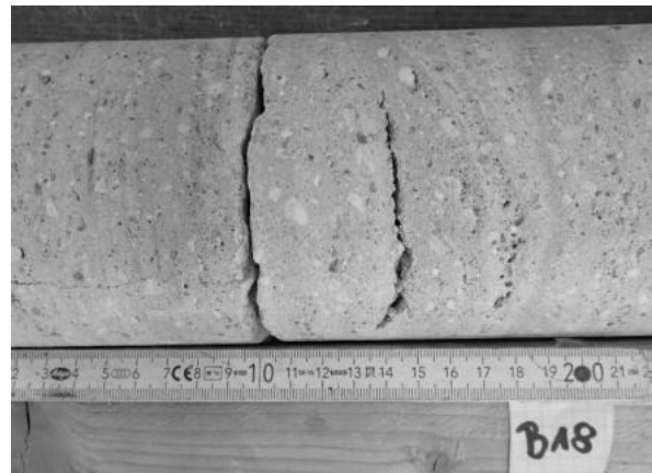
Abbildung 89: Riss am Kern der B18
