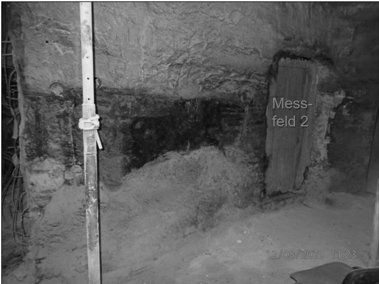
Abbildung 10: freigelegte Mantelfläche und Messfeld 2 für Ultraschalluntersuchungen der BAM
