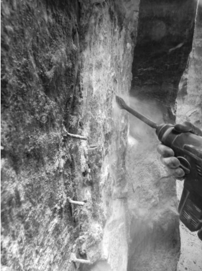
Abbildung 5: Abtragen der Salzschrift mittels Bohrmeißel
