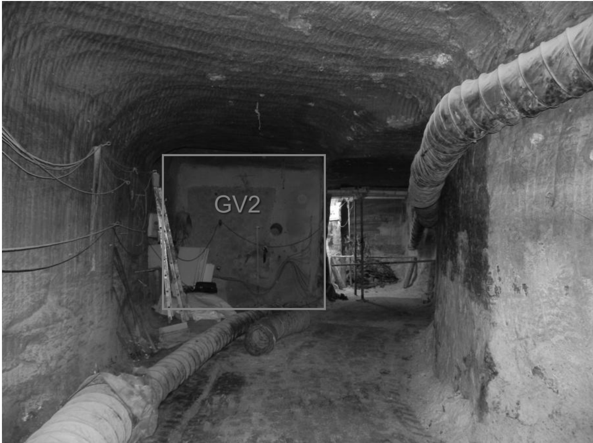
Abbildung 3: Versuchsbauwerk GV2 mit seitlicher Auffahrung
