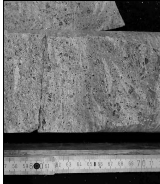
Abbildung 234: Bohrung B34 im GSBV4, lokaler Spalt bei 67 cm Tiefe
