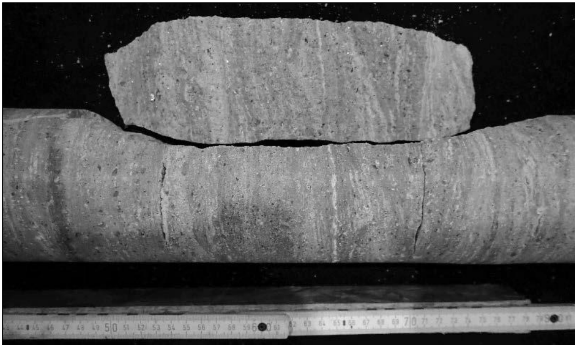
Abbildung 237: Bohrung B35 im GSBV4, weißer Streifen in der Betonstruktur in 65 cm Tiefe
