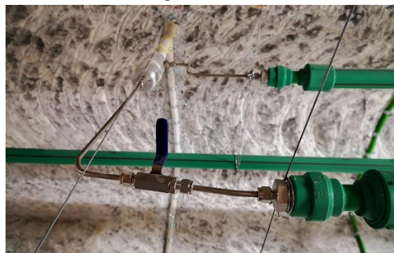
Abbildung 49: Rohranschlüsse an den Ringkammern
