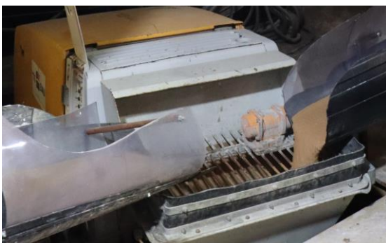
Abbildung 62: Auslaufen des Materials vom Zwangsmischer in die Betonpumpe S5 EV/CM
