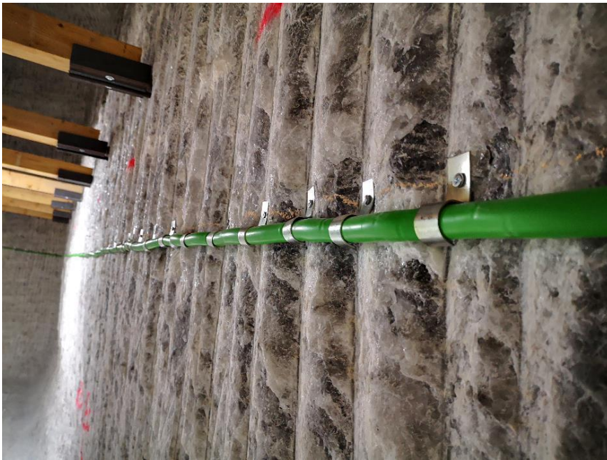
Abbildung 37: Befestigung der Injektionsleitungen am NW-Stoß
