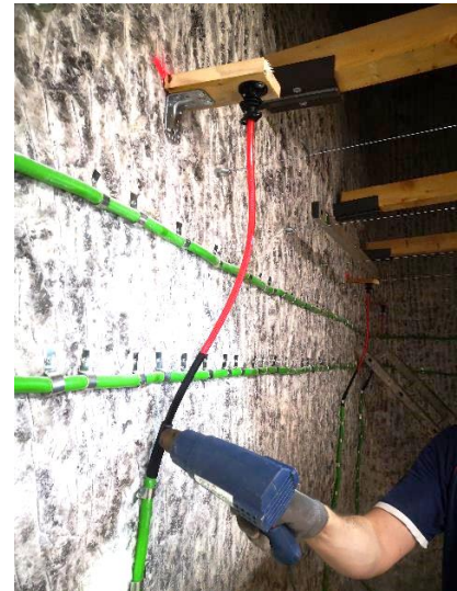
Abbildung 41: Anschluss der vertikalen Injektionsleitungen
