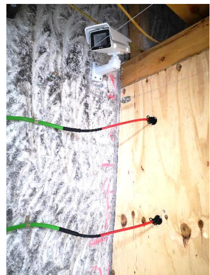
Abbildung 39: Anschluss der horizontalen Injektionsleitungen an der Schaltafel
