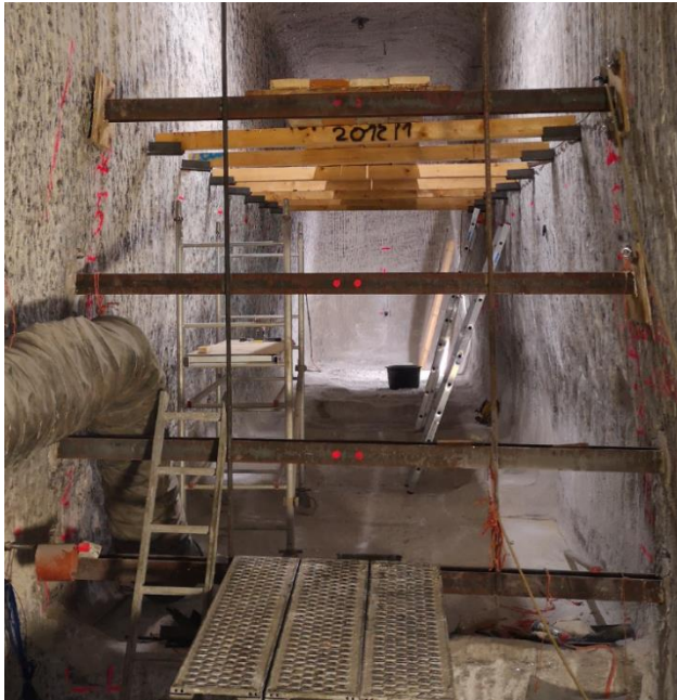
Abbildung 73: I-Träger der Schalung
