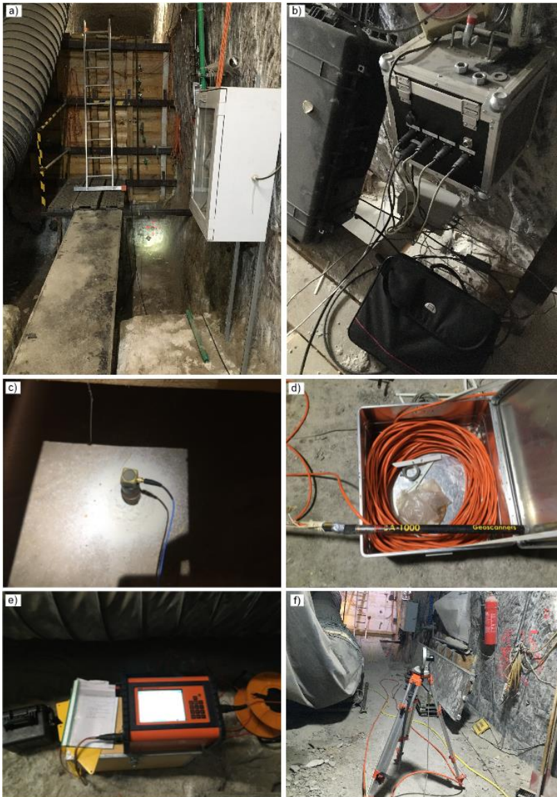
Abbildung 82: a) Dammbauwerk mit den Bohrlöchern für die Geoelektrik, unten links, und Bohrlochradar, unten rechts. Beide Bohrlöcher wurden im Salzgestein unterhalb des Dammbauwerkes abgeteuft, b) Schutzkiste des Datenrekorders der Mikroseismik imc Cronos Flex mit Kabelanschlüssen zu den Schwingungsmessern, c) auf dem Dammbauwerk verschraubter Beschleunigungsaufnehmer Hersteller PCB, Modell 356B18, d) Bohrlochradarantenne Fa. Geoscanners, Modell BA1000 mit 1000 MHz mit Kabel, e) Geoelektrik Steuereinheit Fa. ABEM Terrameter LS, f) Messrad für die Bohrlochradarmessung
