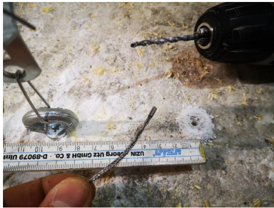
Abbildung 55: Einbau des Temperatursensors T01
