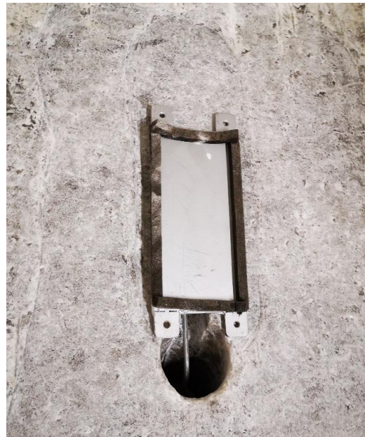
Abbildung 31: KLS-Druckaufnehmer vor dem Einbau der Vergusschalung
