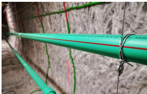
Abbildung 48: Rohrfixierung am Spanndraht (Rohr noch ungeschliffen)
