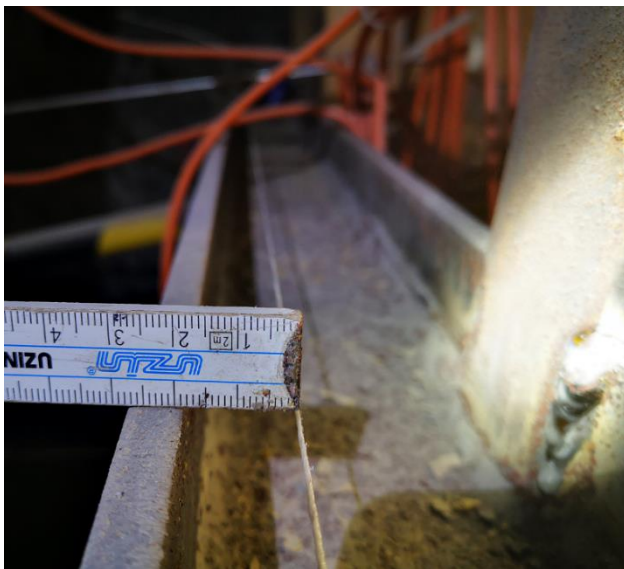
Abbildung 74: Mittige Durchbiegung des 3. I-Trägers
