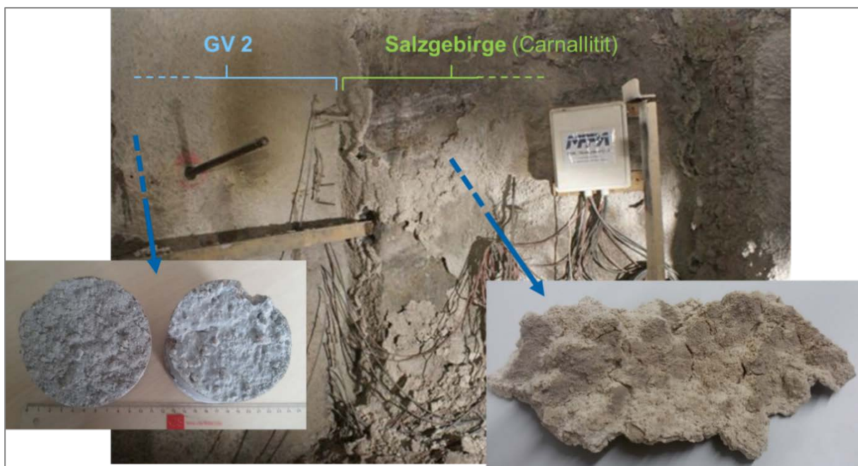
Abbildung 19: GV2-Ortsbrust und angrenzendes Salzgebirge mit krustenartigen Überwachsungen, welche phasenanalytisch an Bohrkernen und Bruchstücken untersucht wurden.
