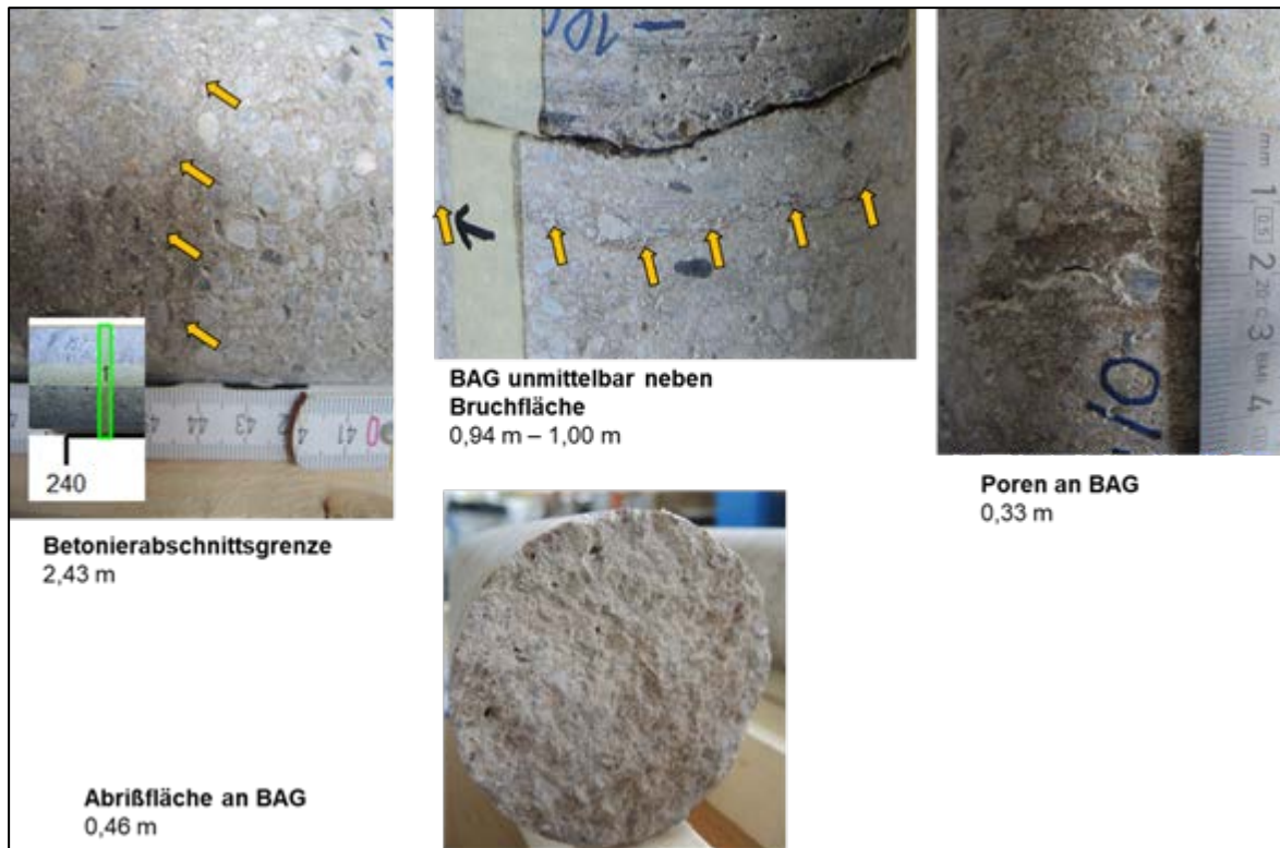
Abbildung 36: Makroskopisches Erscheinungsbild von Betonierabschnittsgrenzen an Kernmaterial der B42 (Detailaufnahmen)
