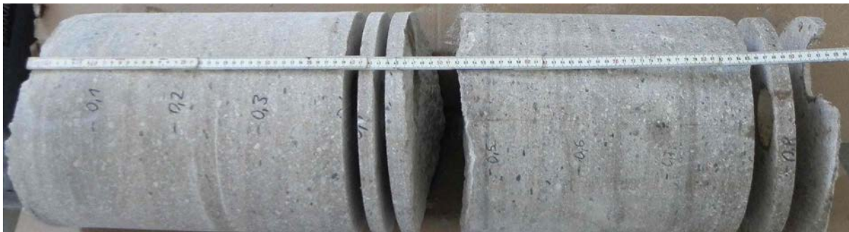
Abbildung 56: Bohrkern der Überbohrung der B34
