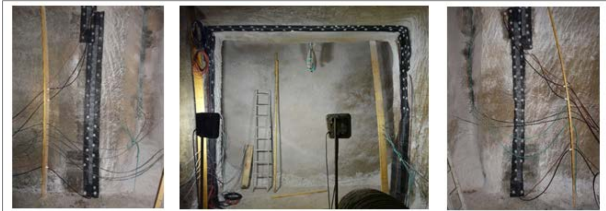
Abbildung 125: Blick auf die Messebene mit Sensor 1 (linker Stoß), Sensor 2 (Mitte oben), Sensor 3 (rechter Stoß)
