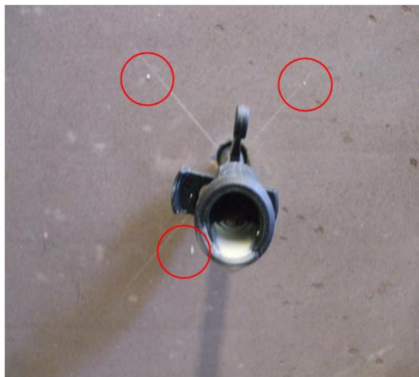
Abb. 53: Austritte des Injektionsmaterials IM 4+ (rote Kreise) auf der Stirnseite des Sandsteins während der Injektion. Die Kantenlänge der Abbildung sind 10 cm.
